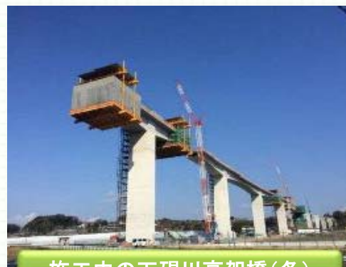
施工中の下碓川高架橋(冬)
