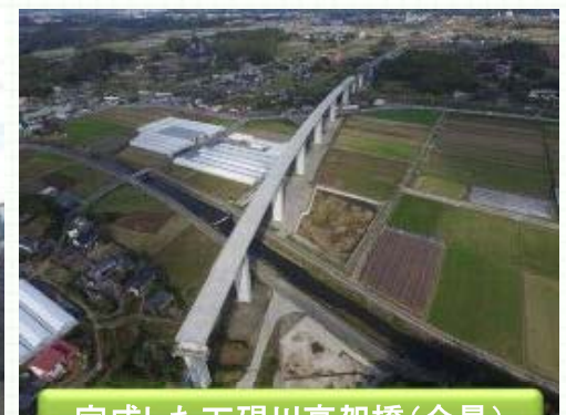
完成した下碓川高架橋(全景)
