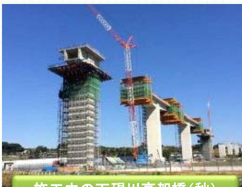
施工中の下碓川高架橋(秋)
