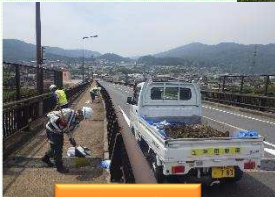
歩道の土砂撤去
