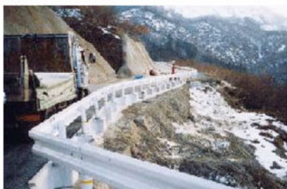
切土岩盤部に設置
