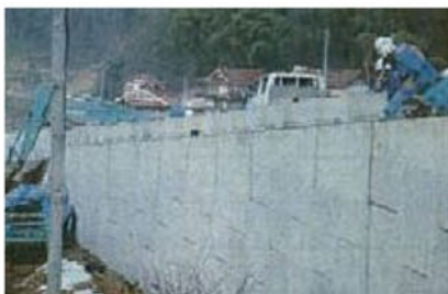
補強土壁上に設置
