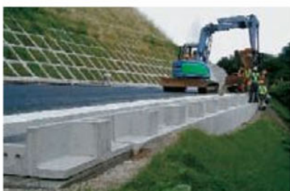
L形擁壁上に設置
