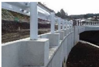
逆T擁壁上に設置
