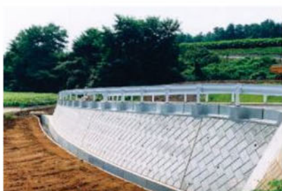
積みブロック上に設置
