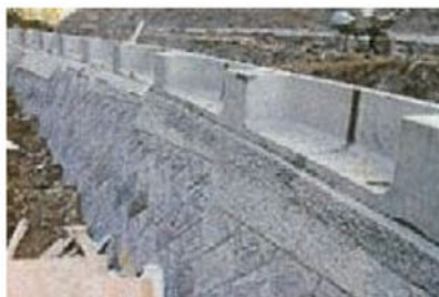
積みブロック上に設置
