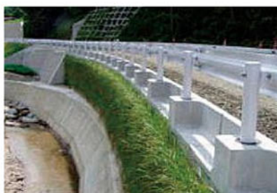
盛土部に設置
