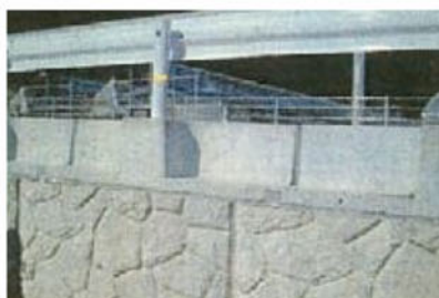
L形擁壁上に設置
