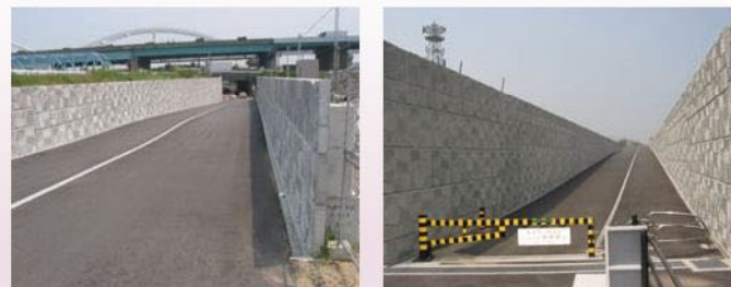
【大阪府】H=2~7m L=85m×2 落石防止対策・壁高分割発注
