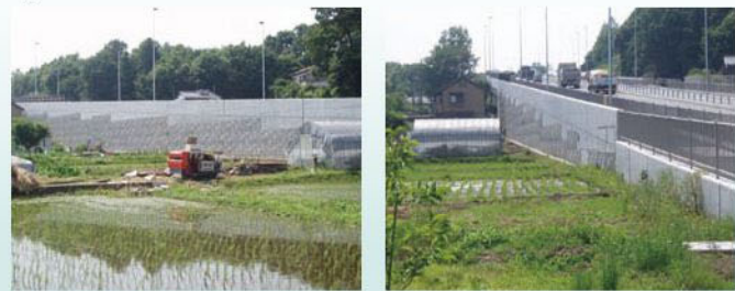
【東京都】H=3~9m L=125m 民家隣接・道路内埋設物対応
